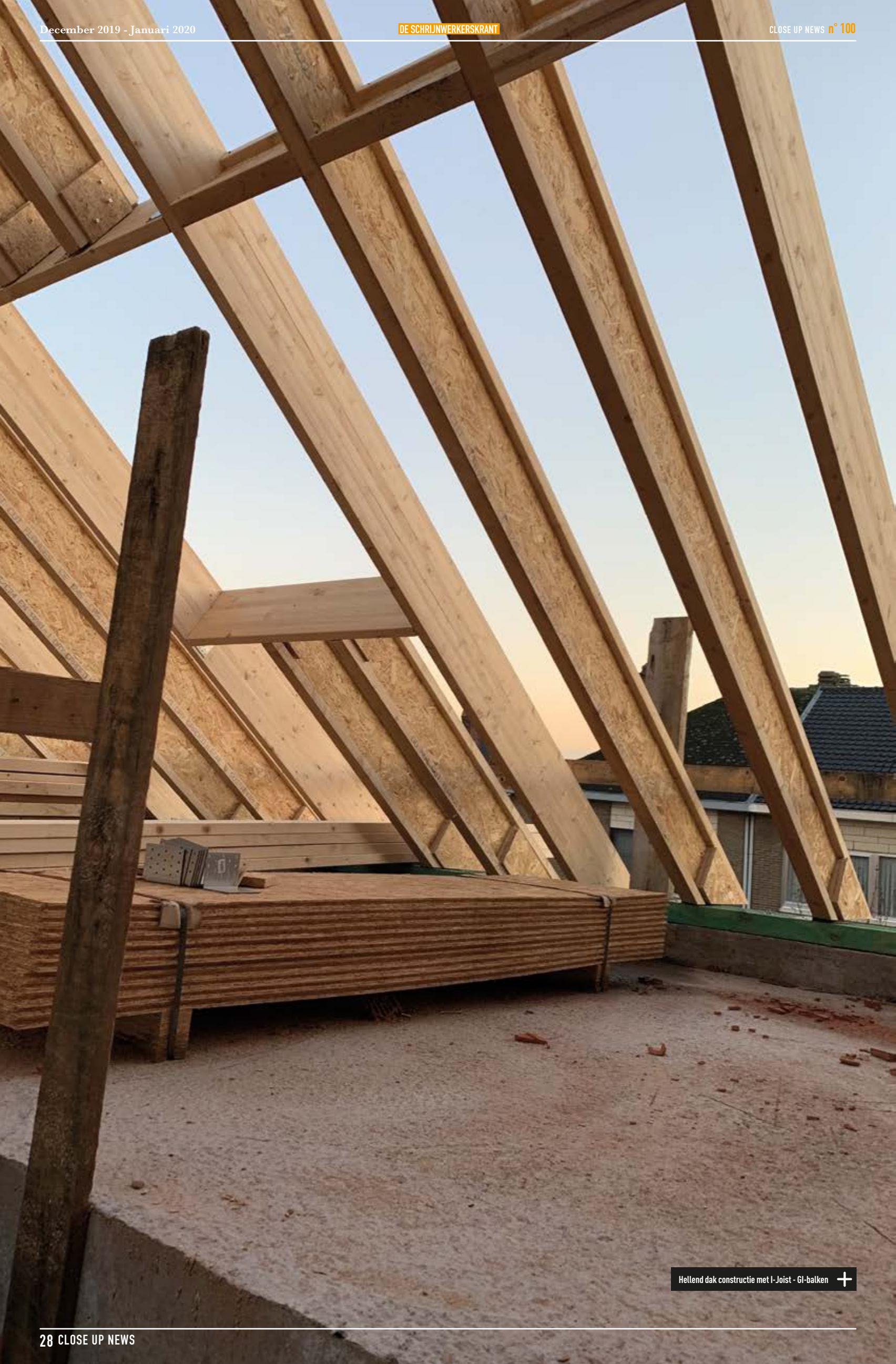
+ Alle balken werden op voorhand gefreesd en gezaagd door VC Wood
