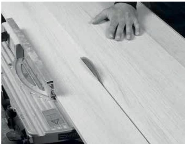
**PREMIER PANNEAU :** Commencez par l'angle du mur et adaptez le premier panneau. Il peut déjà être scié avec un bord droit et une partie rainure. Placez le premier panneau avec le côté scié au départ de mur à couvrir au bord droit dans l'angle, de sorte qu'il s'encliquette dans la rainure du suivant.
