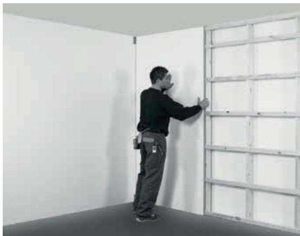
Répétez l'opération pour chaque panneau jusqu'à ce que le mur soit entièrement recouvert. Terminez par le panneau scié sur mesure auparavant et dont le côté languette s'encliquette dans le panneau correspondant. De sorte, le bord scié se retrouve dans l'angle final du mur à couvrir.
