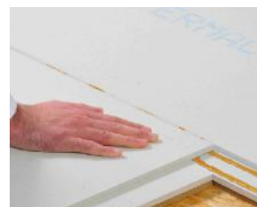
Collage des plaques avec des joints complètement remplis
