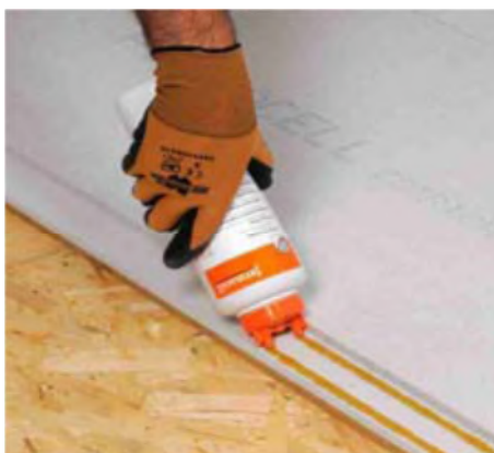
Aanbrengen van de fermacell Vloerelementen montagelijm in twee strengen op de liplas
