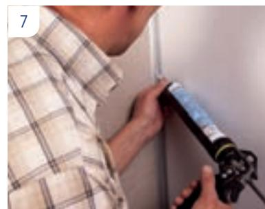
In de nog vrije hoek wordt het profiel bevestigd tegen de muur. Breng opnieuw silicone in het profiel, zaag de groef van het eerste paneel dat in het profiel moet en werk verder.
