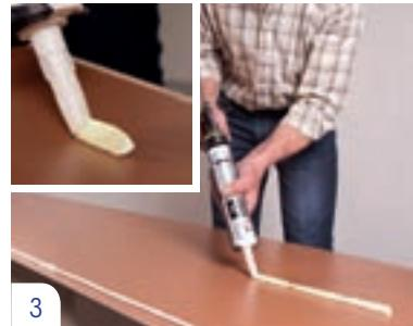
Werk met de klok mee. Breng een elastische, sterke montagelijm\*\* aan op de achterzijde van het paneel: 3 lijmstrengen in de lengte richting van de plaat. Plaats het paneel tegen de wand en druk goed aan.
