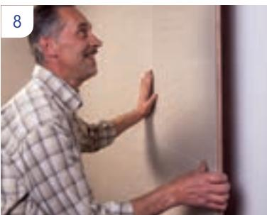
Voorzie in elke verticale voeg (in de profiling) sanitaire silicone om deze waterdicht te maken. Laat de overtollige silicone opdrogen. Als deze droog is, kan je dit met een scherp mesje weg snijden.
