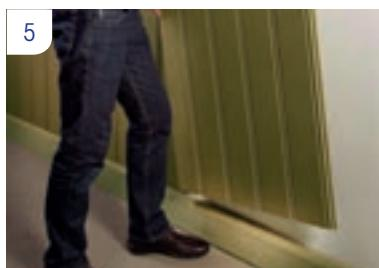
Plaats de panelen op de plint en druk goed aan (indien gewenst, kan stap 2 overgeslagen worden). De plinten kunnen ook voor de panelen geplaatst worden i.p.v.eronder).
