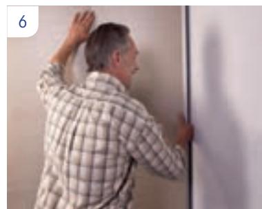
Bevestig het hoekprofiel op het paneel alvorens dit te plaatsen. Vergeet de sanitaire silicone niet!
