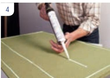
Breng lijm\* aan op de rug van het paneel op ca 10 mm van de rand en 3 strengen in het midden over de langste zijde.
