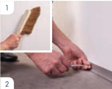
1. Laat de panelen acclimatiseren en zorg dat de ondergrond voldoende vlak, droog, vast, zuiver, stof- en vetvrij is. De ondergrond lichtjes opschuren geeft een beter resultaat.
