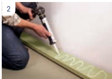
Breng montagelijm\* aan op de rug van de plint. Gebruik lijm die blijvend elastisch is.
