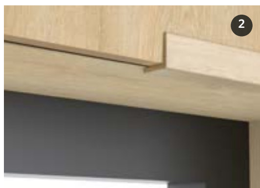
Finition fenêtre avec profilé angulaire souple.
