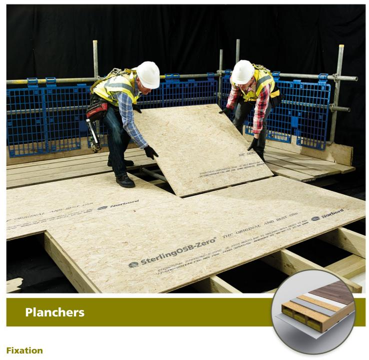
Les panneaux sont toujours posés en quinconce. Le côté court des panneaux Les panneaux à bords droits sont supportés sur tous les bords. repose toujours sur une poutre (minimum 18 mm).
