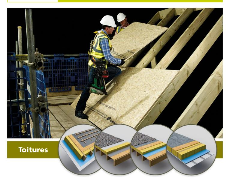
Les constructions à ossature bois sont imbattables en termes de rapport épaisseur/pouvoir isolant de l'élément de construction grâce à la combinaison de leur force portante et du niveau d'isolation. Cet avantage peut désormais aussi être utilisé pour des toits. L'étanchéité de toiture ou la couverture est directement placée sur les panneaux extérieurs. Dans la
